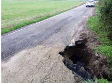
2) Nell'aprile 2018 il comune ha provveduto a realizzare un'opera che impedisse alla strada di sprofondare del tutto a causa dell'erosione dell'acqua meteorica. Il lavoro, consistente nel taglio del manto stradale, di un piccolo scavo per dell'inserimento di una tubazione in cemento con la funzione di canalizzare l'acqua e farla defluire senza erodere il terreno sottostante la strada, e nella successiva asfaltatura di rappezzo.
